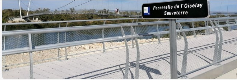
La passerelle suspendue permet de relier le nord du Vaucluse aux remparts d'Avignon © Radio France - Romain Berchet
